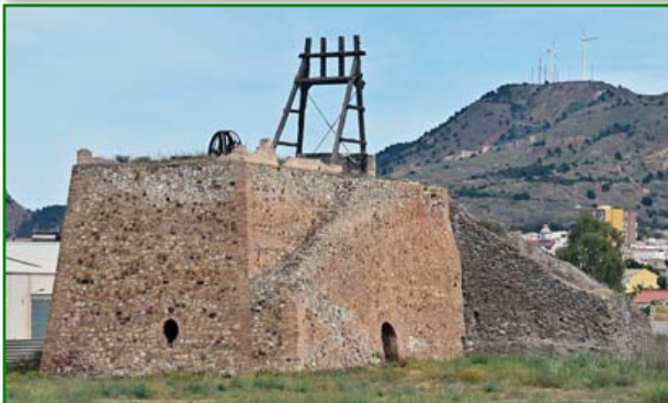
Mina Ocasión, Pozo Alfonso, flat rope winder remains.
